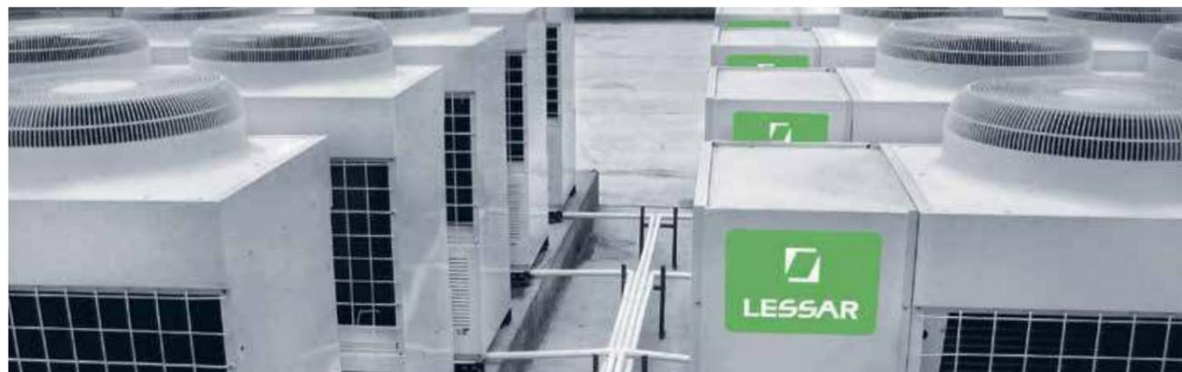
Модульные чиллеры с воздушным конденсатором LESSAR — высокоэффективные энергосберегающие компактные системы. Возможность свободно комбинировать модули в соответствии с необходимой тепловой нагрузкой позволяет достичь суммарной холодопроизводительности системы до 2080 кВт, что обеспечивает широкий спектр применения.
